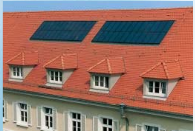
Photovoltaik-Anlage auf dem Dach der KUNDENBERATUNG der Stadtwerke Karlsruhe in der Kaiserstraße
