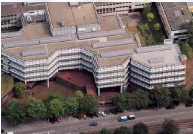
Das Karlsruher Sonnendach: eine Anlage von 300 privaten Anteilseignern auf dem Dach der Verwaltung der Stadtwerke Karlsruhe – mit 50 kW Leistung größte, modernste und leistungsfähigste netzgekoppelte Anlage in der Stadt.
